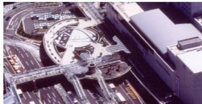
整備後の上空写真
