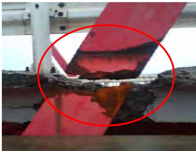
木曽川大橋：トラス橋斜材の破断
