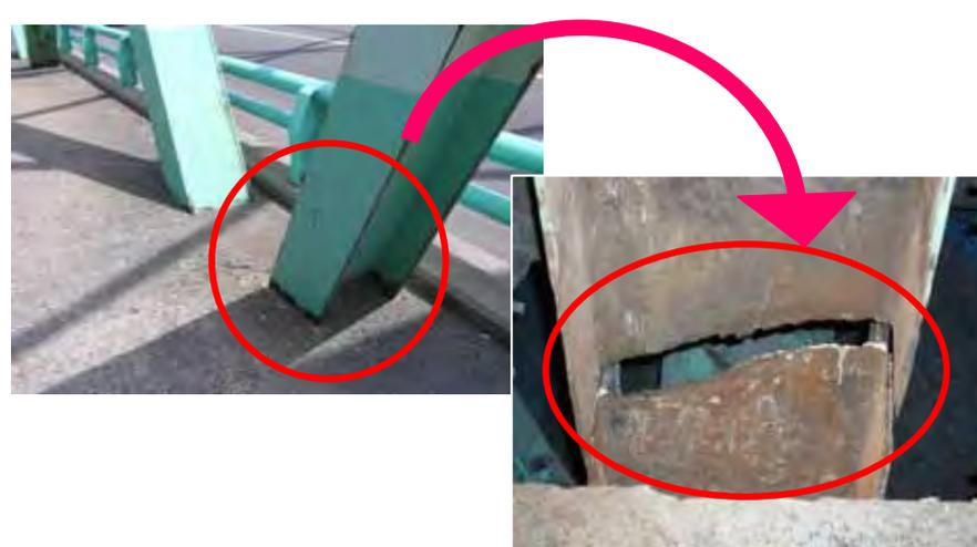
本荘大橋：トラス橋斜材の破断
