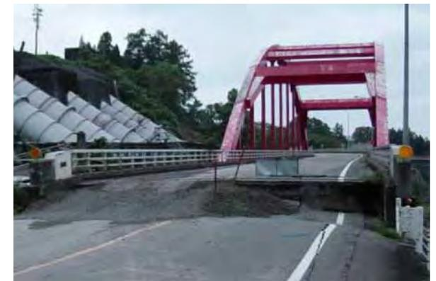
【2004年新潟県中越地震】橋台背面の陥没
