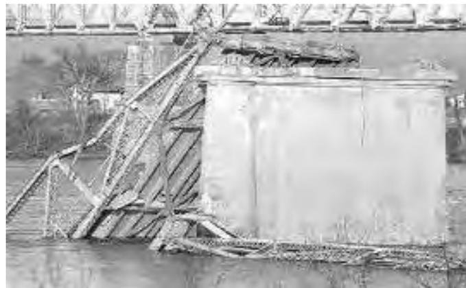
ケーブルの疲労(破壊)により落橋
