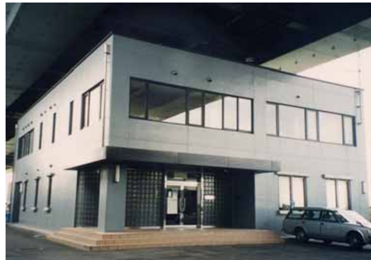
泉佐野営業所(湾岸線)【建物】 2
