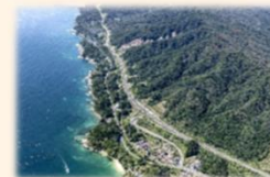
三陸沿岸道路(岩手県山田町)
