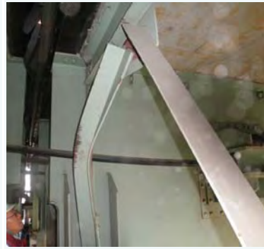
仙台東部道路 (仙台東～仙台港北)
