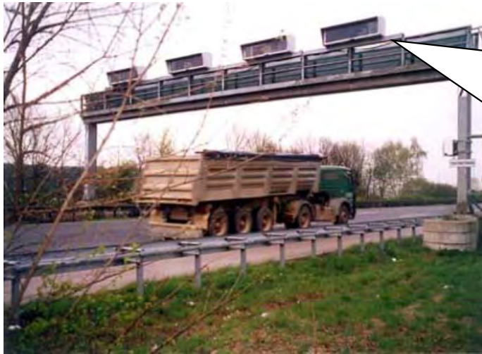
コントロールゲート
