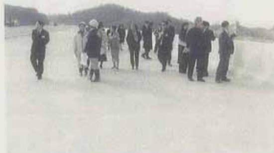
施工中道路(橋梁部)見学の様子
