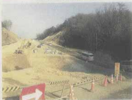
施工中道路(土工部)見学の様子
