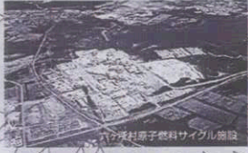
六ヶ所再処理燃料サイクル施設
