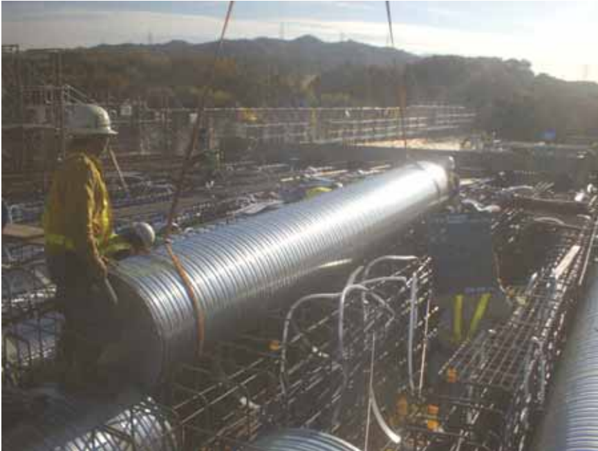
写真-3 円筒型わく設置状況
