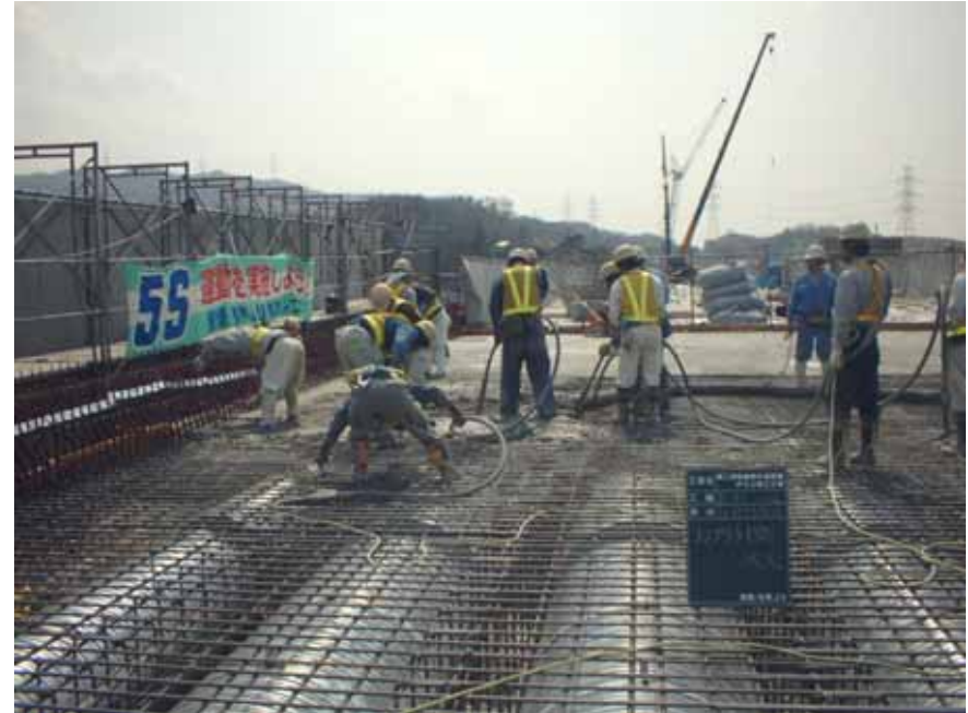
写真-4 コンクリート打設状況
