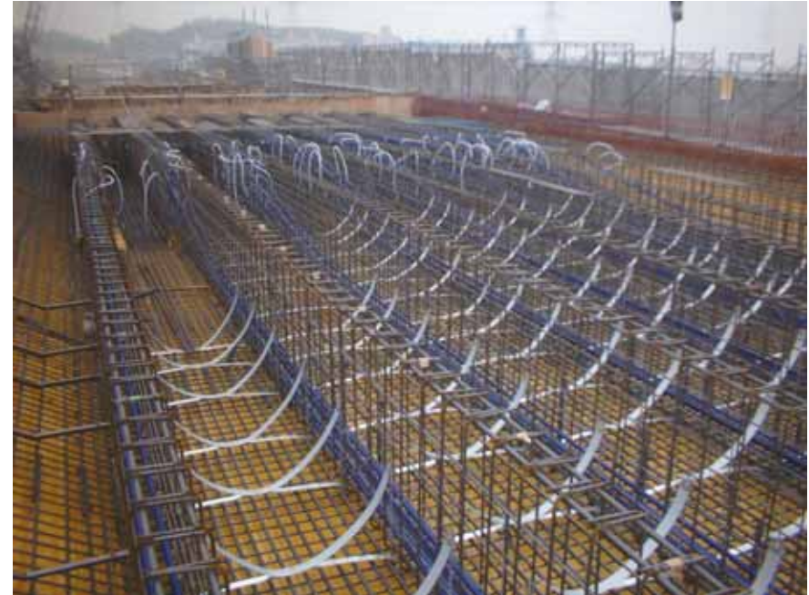
写真-2 鉄筋組立状況
