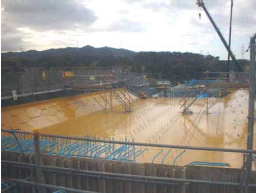
写真-1 型わく設置状況
