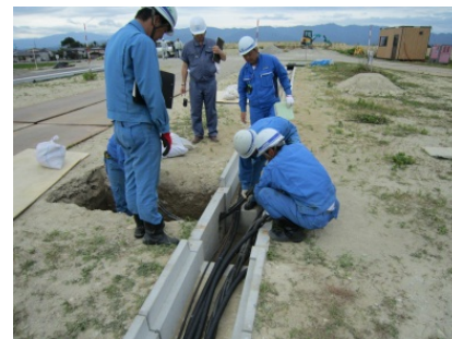
低コスト手法の施工性確認の状況
