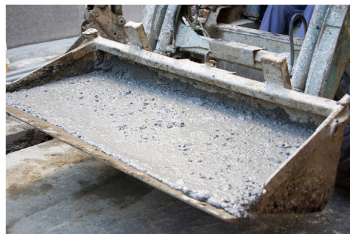
台湾：CLSMを利用した埋め戻し
