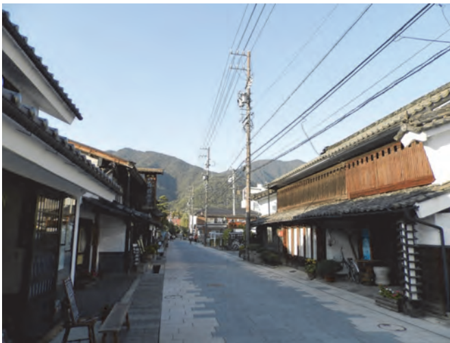
【長野県上田市】 風情ある伝統的建造物群にそぐわない電柱・電線。
