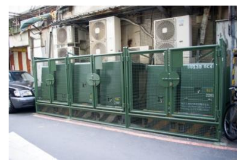
歩道なしの路地に設置された変圧器
