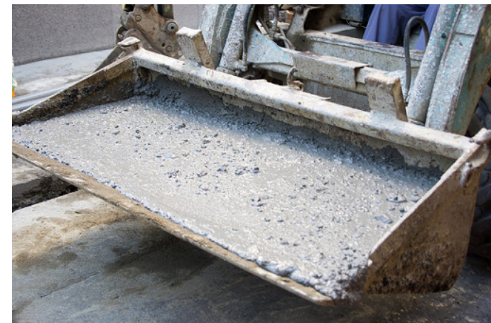
台湾：CLSMを利用した埋め戻し
