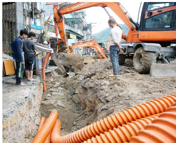
埋設工事の状況(ハノイ市内) 出典: VNReview
