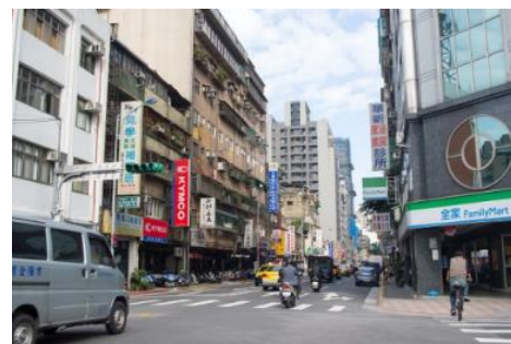
旧市街地の無電柱化状況
