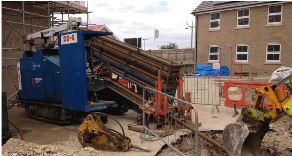
英国：HDD (Horizontal Directional Drilling) 機材
