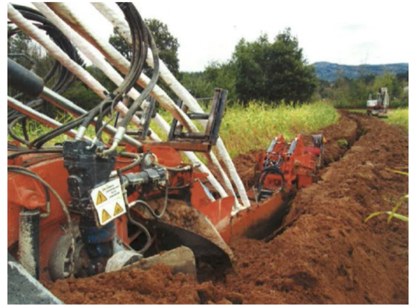
フランス：ケーブル直接埋設の専用機材
