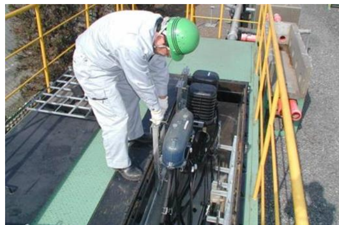
地上での接続作業時
