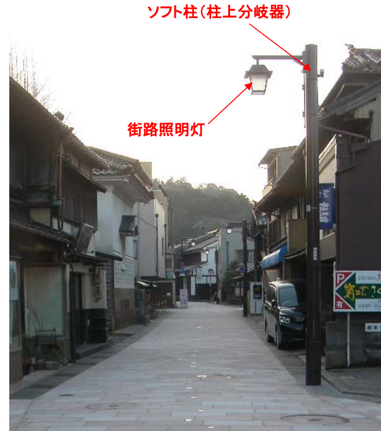
街路照明灯へ柱上型分岐器を配置 （ソフト地中化）
