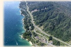
三陸沿岸道路 (岩手県山田町)
