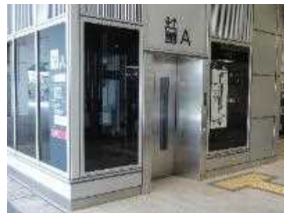
エレベーターの設置
