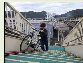
駅設備の対応 (階段へのスロープ設置) JR西日本きのくに線 (和歌山県)
