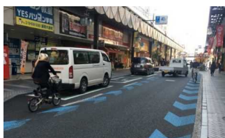
＜荷さばき停車帯と通行空間の整備例(盛岡市)＞
