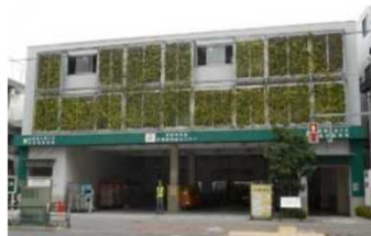
＜路外共同荷さばき施設 (吉祥寺商店街共同集配送センター) (東京都武蔵野市)＞
