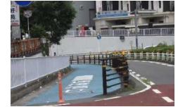
<自転車道の標示(神奈川県川崎市)>
