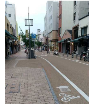
<無電柱化と合わせた通行空間の整備例(愛媛県松山市)>
