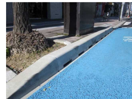
<自転車の走行性に配慮した排水構造の例(広島県福山市)> 【出典:国土交通省】
