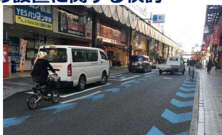
<荷捌き停車帯と通行空間の整備例(盛岡市)>
