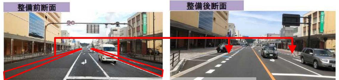
車線 ⇒ 自転車通行空間 福井県敦賀市
