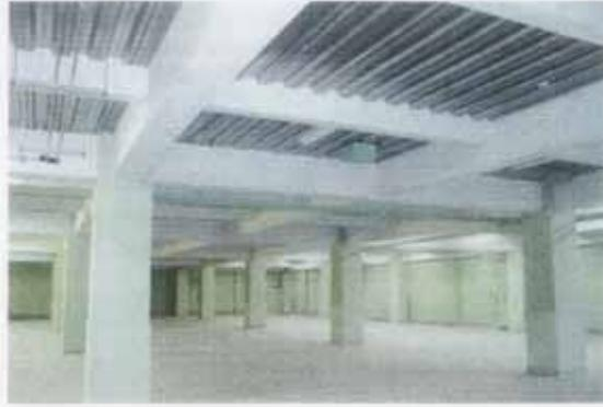
写真 3—6 石綿含有耐火被覆板の使用例
