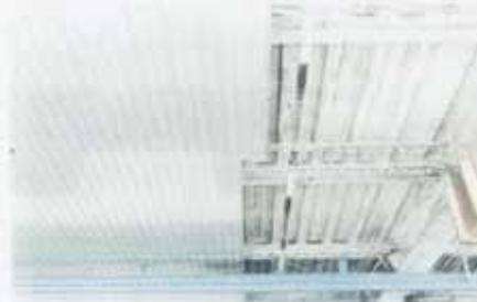
写真 3—8 屋根用折版裏断熱材の使用例
