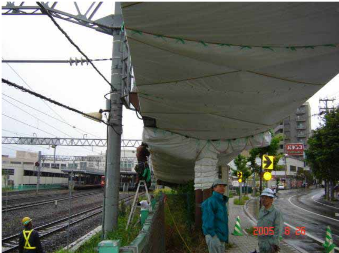
樽川人道跨線橋 対策状況（南側通路）
