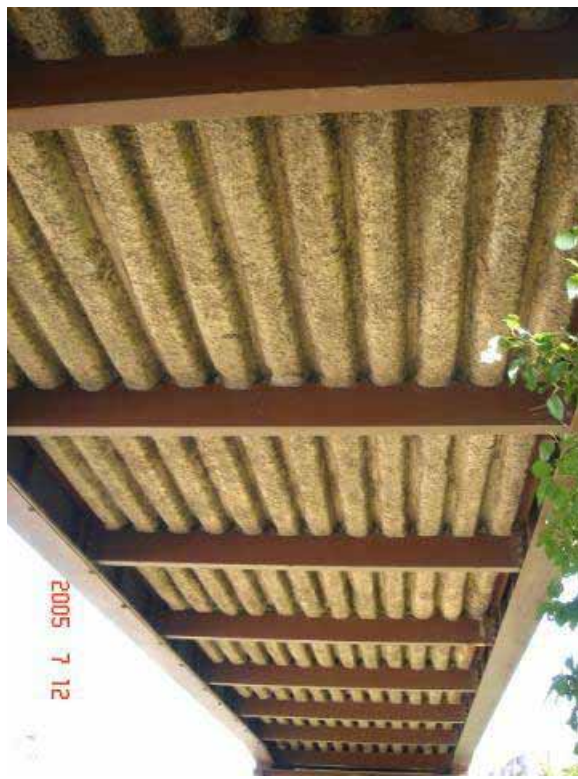
樽川人道跨線橋 北側通路（吹付状況）
