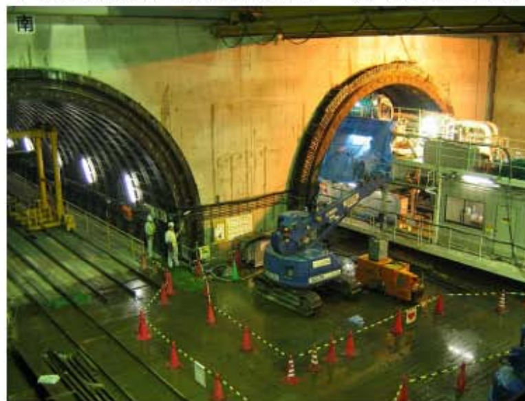
中央環状新宿線(上落合シールド施工状況)
