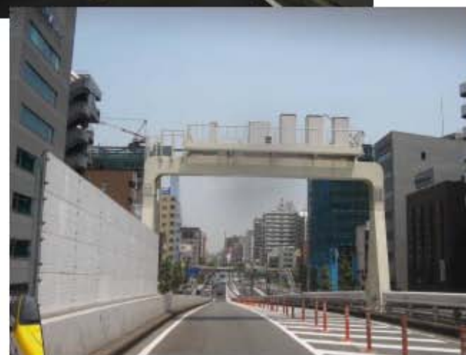
出口ETC機器(入谷出口)
