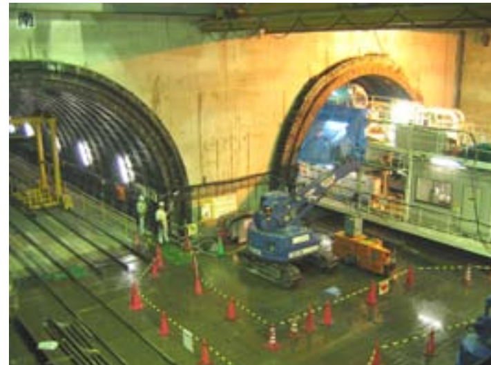
中央環状新宿線(上落合シールド施工状況)
