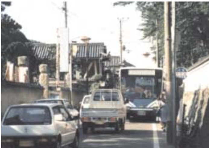
図7-3 安全・快適に移動できない現道の状況
