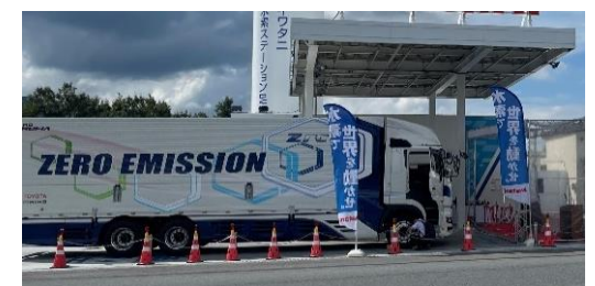
足柄SA（下り）に設置された水素ステーション
