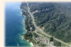
三陸沿岸道路 (岩手県山田町)
