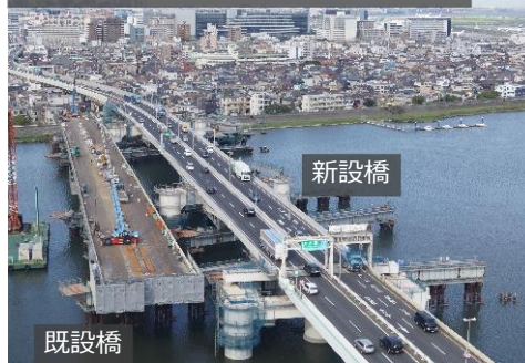
② 新設橋設置後（撮影日：R5.9.27）
