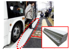
【隙間を空けずに停留所に停車可能な縁石】
