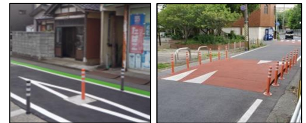
進入抑制対策および速度抑制対策の例 (ライジングボラード、ハンブ)
