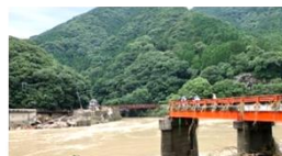
令和2年7月豪雨...熊本県道
