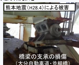
橋梁の支承の損傷 (大分自動車道・並柳橋)
