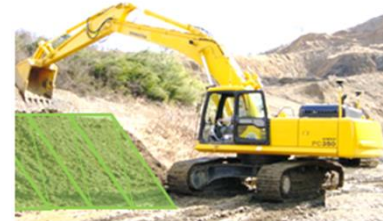
ICT施工の活用
