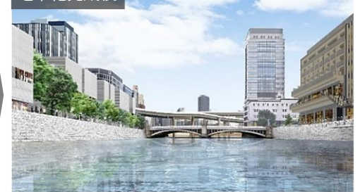
地下化完成後
