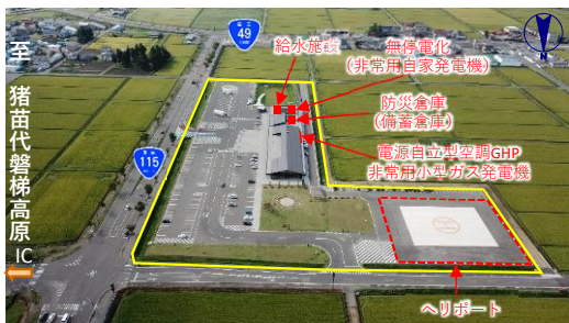
防災道の駅「猪苗代」の防災機能強化
