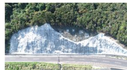
法面吹付工、落石防止網工
