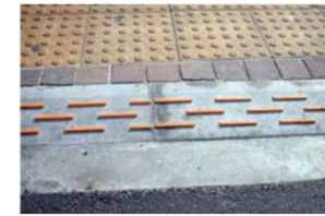
【視覚障害者、車椅子利用者等に配慮した横断歩道縁端】
