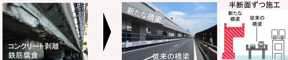
構造物全体の架け替えを実施
