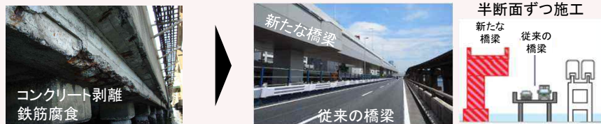
構造物全体の架け替えを実施
