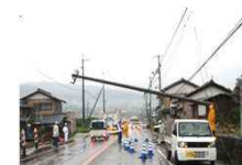
沿道の電柱の倒壊による道路閉塞
