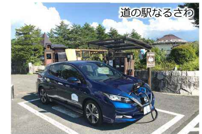
道の駅でのEV充電施設の設置
