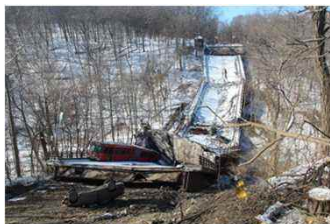
ファーン・ホロー橋崩落（2022年） （国家運輸安全委員会（NTSB）HPより）
