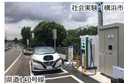
公道でのEV充電施設の設置
