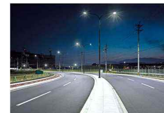
LED照明による省エネ効果 消費電力約6割削減 (高圧ナトリウム灯比)
