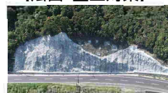
法面吹付工、落石防止網工
