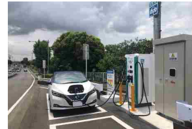
< EV充電施設の公道設置実験（横浜市） >
