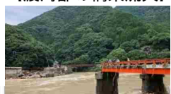
令和2年7月豪雨...熊本県道
