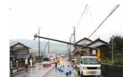
沿道の電柱の倒壊による道路閉塞
