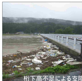
撤去による治水効果の向上を通じ地域の安全・安心を確保
