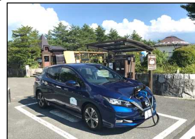
< 道の駅でのEV充電器の設置 >
