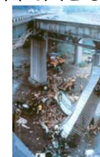
マイアス橋の崩壊(1983年)
