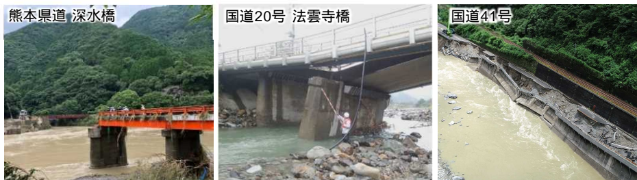
熊本県道 深水橋 橋梁流失 令和2年7月豪雨 (3ヶ月以上の通行止め) 国道20号 法雲寺橋 橋脚洗掘・沈下 令和元年台風19号 (1ヶ月半の通行止め) 国道41号 道路流失 令和2年7月豪雨 (1ヶ月半の通行止め)
