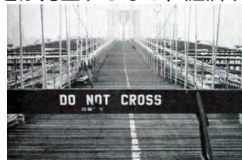
ケーブル切断事故後、通行止めになったブルックリン橋の歩道 (「高速道路と自動車」1981年11月から引用)
