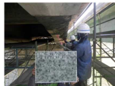
修繕の様子(断面修復)
