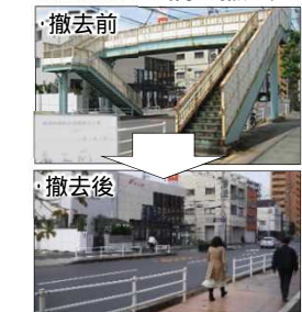
バリアフリーな歩道空間確保のため老朽化した横断歩道橋を撤去
