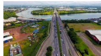
<ジャカルタ・マカッサル高速道路>
