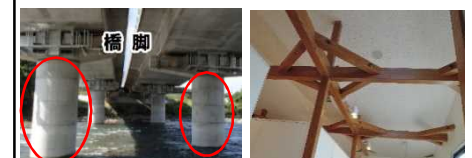
<橋梁の耐震対策> <道の駅の耐震対策>
