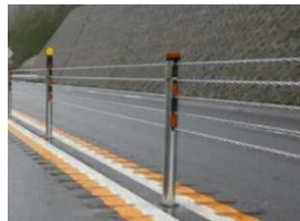
<ワイヤロープの設置事例>
