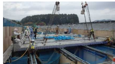
<床版取替工事の状況>
