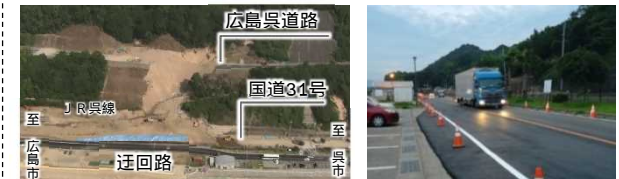
広島県道路・国道31号の被害状況
