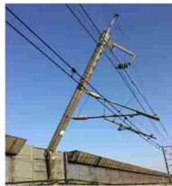
電柱の折損
