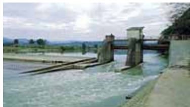
雲出井頭首工
