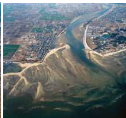
雲出川本川河口（0km 付近）
