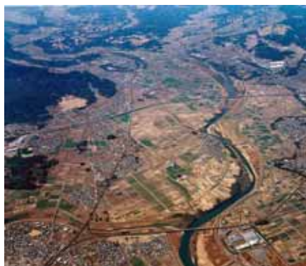
雲出川本川下流（7～10km 付近）
