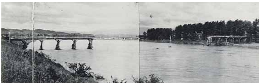
大正橋の落橋（一志郡嬉野町川原小造） 昭和 34 年 9 月洪水(伊勢湾台風)
