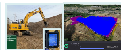
ICT建機・プラットフォーム進捗管理
