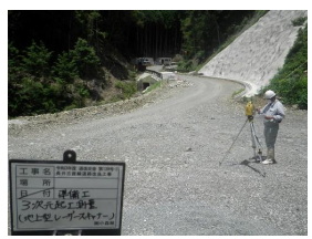
TLS(自社所有)による 起工・出来形測量
