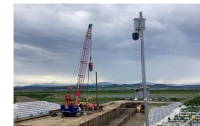
現場に設置したWEBカメラ
