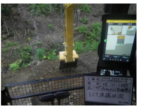
MC建機(自社所有)に よる床掘
