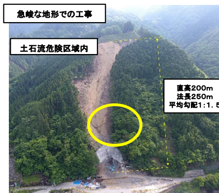
工事現場全景
