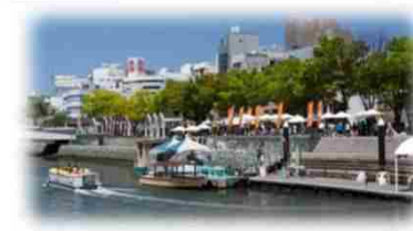
親水護岸の利用 (新町川/徳島市)
