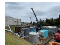
可搬式浄水装置の設置 （珠洲市）
