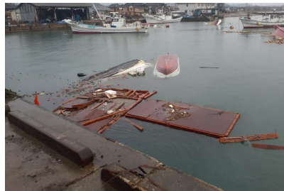
津波による漁船等の転覆(飯田港)
