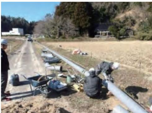
熊谷汚水中継ポンプ場から珠洲市浄化センターまでの仮設圧送管の布設（石川県珠洲市）
