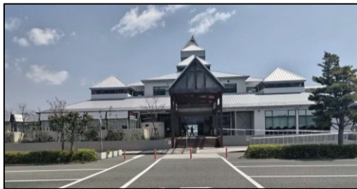
熊本港フェリーターミナル
