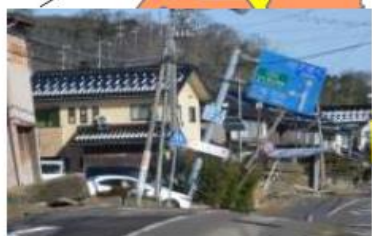
内灘町西荒屋地内（液状化）
