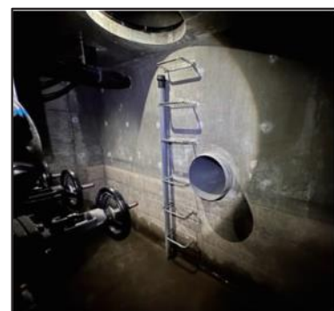
雨水貯留槽内の水位計設置状況
