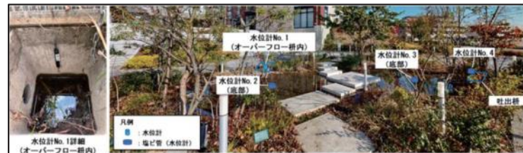
雨庭の水位計設置状況
