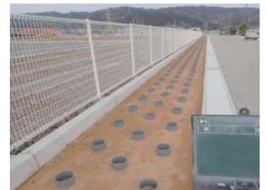
写真-7 施工事例(防草・緑化)
