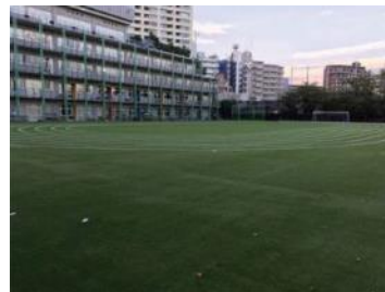
写真-6 施工事例(人口芝下地)
