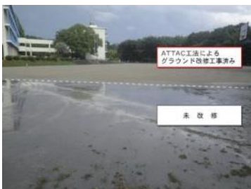
写真-4 施工事例(グラウンド)
