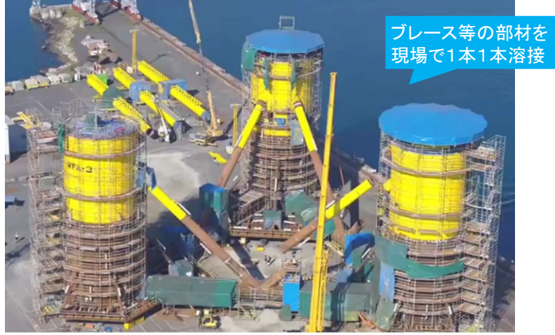
□Windfloat Atlanticの施工例（スペインFerrol港）
