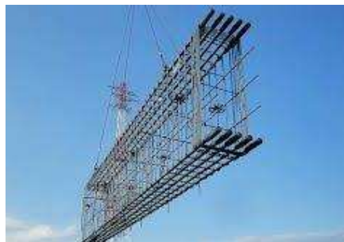
梁鉄筋地組取付
