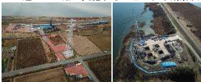
ドローン画像による現場状況確認
