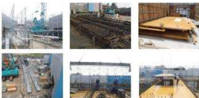
地組(足場・型枠・鉄筋)のイメージ
