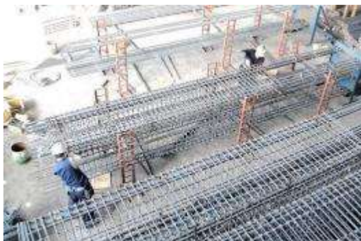
梁鉄筋工場地組
