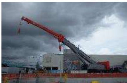
ラフタークレーンによる施工
