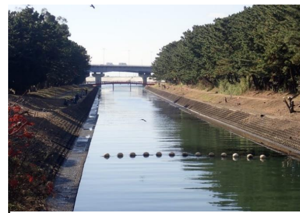
行政代執行実施後の状況
