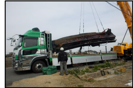
【R3年度撤去工事】
