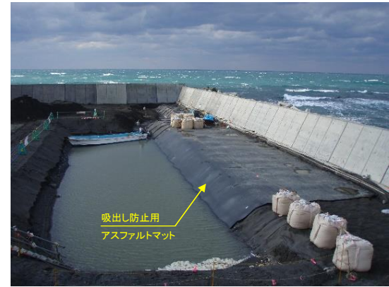
写真-2 敷設後のアスファルトマット
