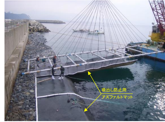
写真-1 アスファルトマット敷設状況
