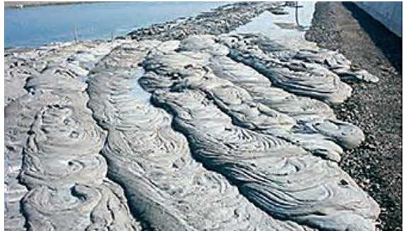
写真2 護岸背面捨石表面への施工状況
