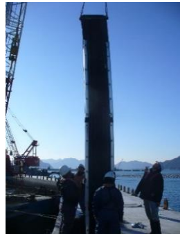
図3 挿入状況写真
