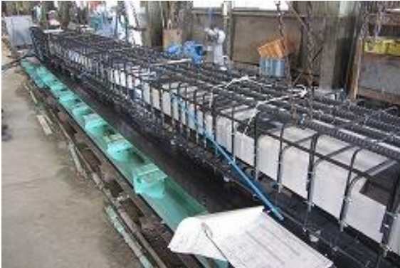
補強材組立状況
