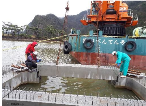
梁部材の据付・連結
