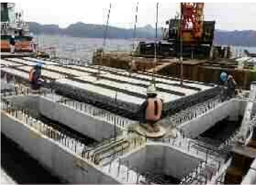
床版部材の据付
