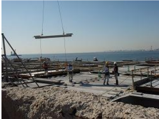
架設状況写真(1)
