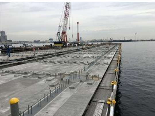
架設状況写真(2)
