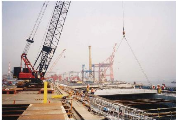
PCホロ一桁架設状況
