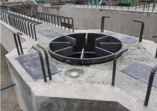
杭との接続部
