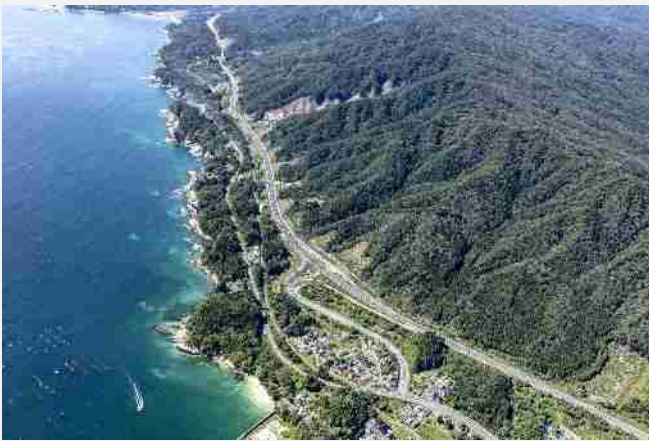
三陸沿岸道路（岩手県山田町）
