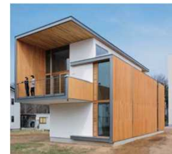
CLT工法による実験棟
