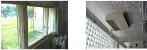
学校等の防音工事(防音サッシ・空調機)
