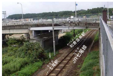
全景(写真①)
