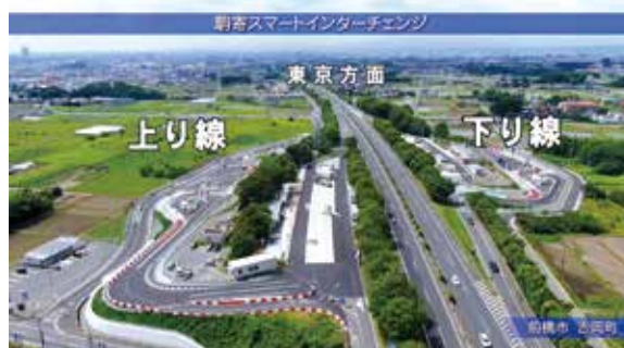
図表2-3-2 大型車対応となった駒寄スマートIC
